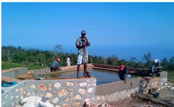
Crépissage et Mise en eau d'un Réservoir ouvert
