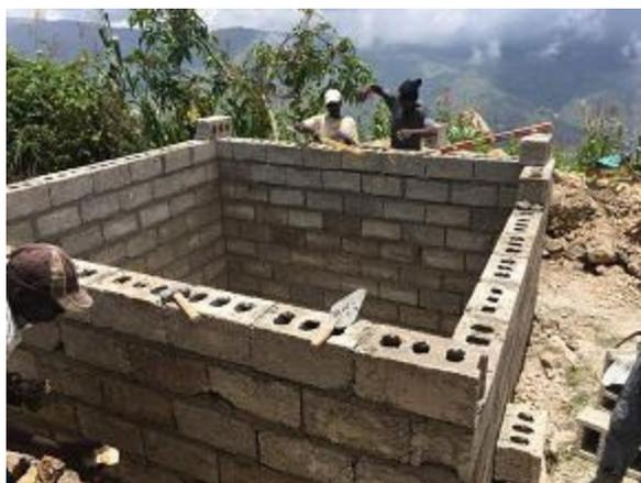
Elévation des parois du Réservoir avant crépis et enduit
