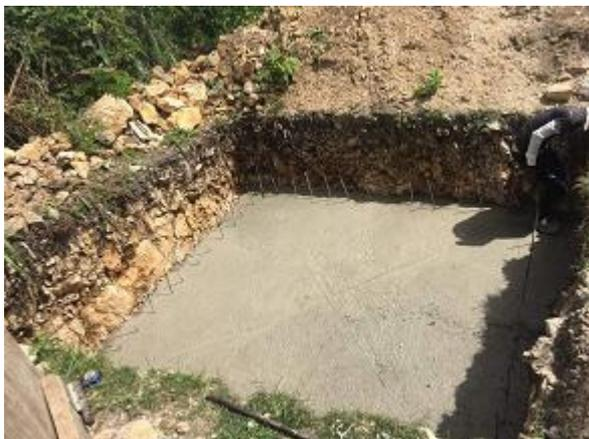
Fouilles + Coffrage + Ferrailage + Coulage de la Dalle Béton
