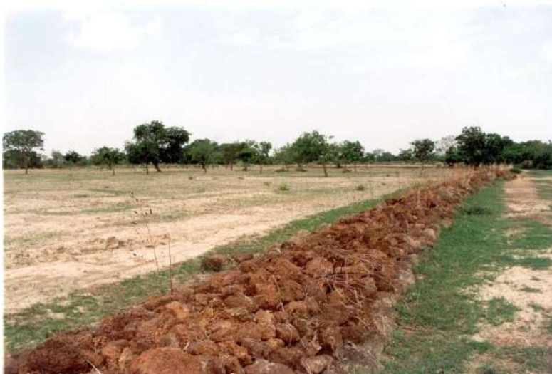
Photo 2 : Diguettes filtrantes à l'aval d'un champ
