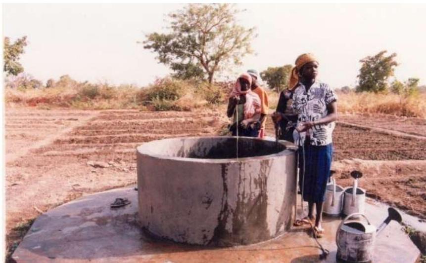
Photo 29: Puits à grand diamètre
