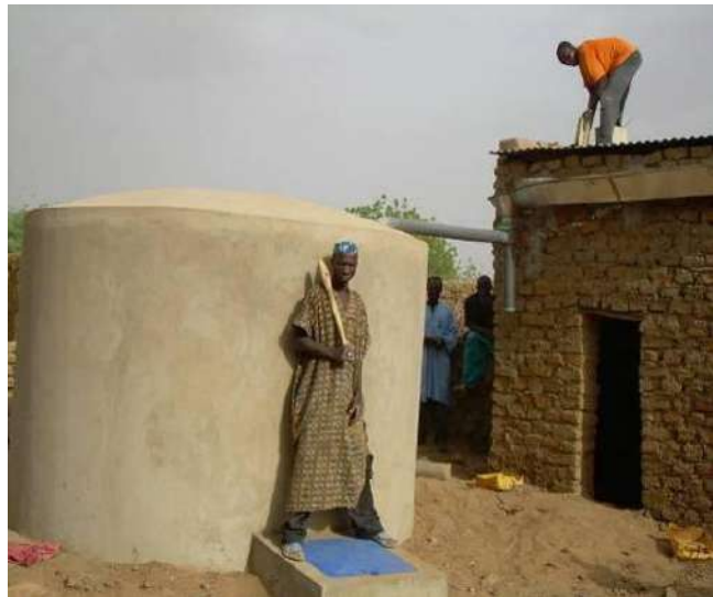
Photo 26: Impluvium en ferrociment
