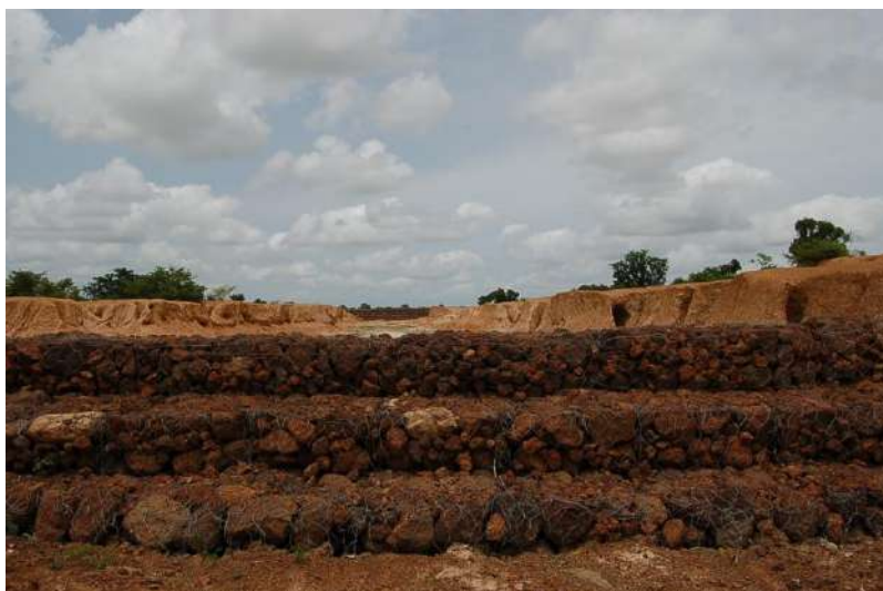
Photo 3 : Diguettes filtrantes au niveau d'une ravine
